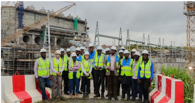
Visite du chantier de Nachtigal, le 19/04/2023
