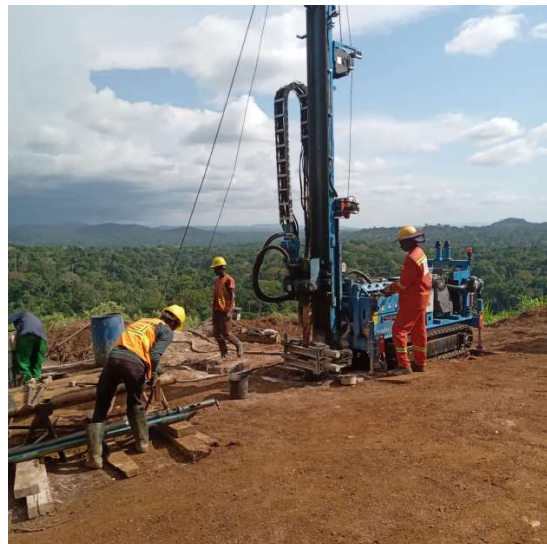
Forage sur le site de la carrière à Binoum – 14 mai 2022
